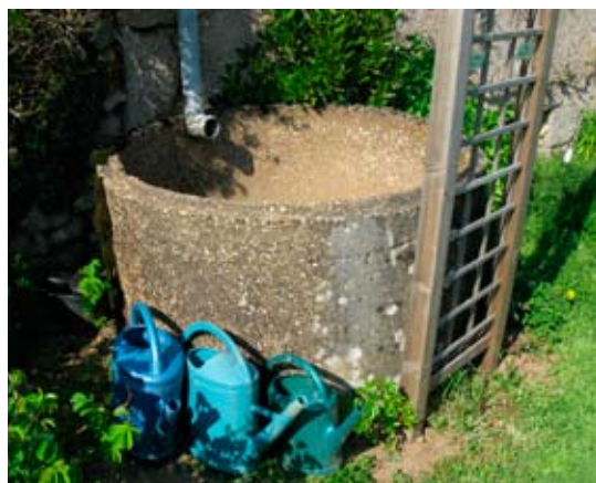
Photo 18 : cuve de récupération d'eau de pluie
